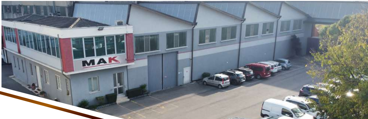
MAK S.p.A. production plant in Gussago / MAK S.p.A sede produttiva Gussago
